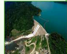
MURUM HEP (944 MW)
